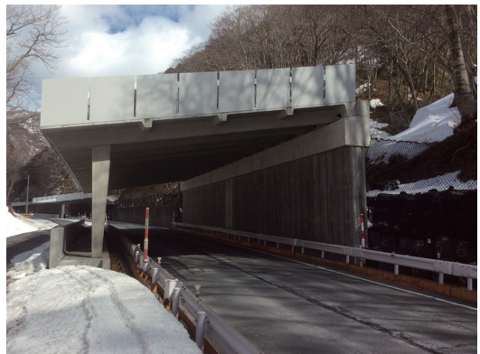
スノーシェッド側壁
