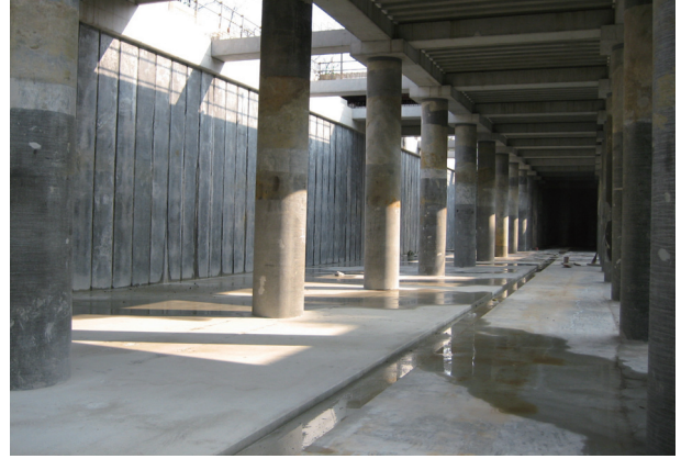
地下式調整池
