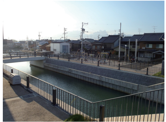
河川護岸・橋台下部工
