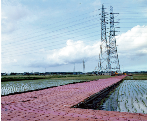
送電線鉄塔建設現場における仮設搬入路
