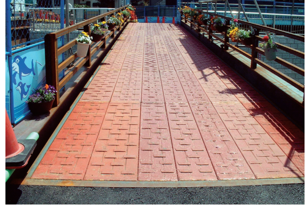
仮設人道橋の床版用途
