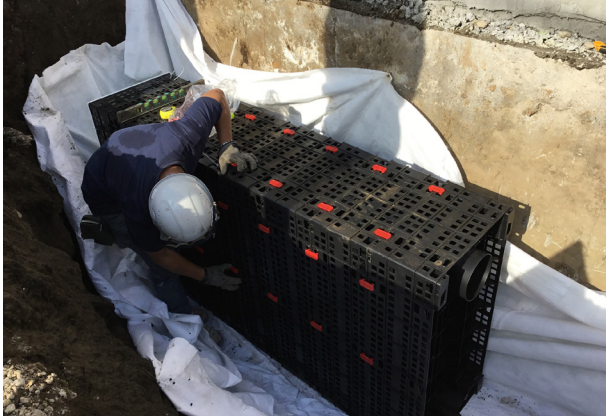
ニュートレンチくん-II 組み立て状況
