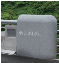
湯西川ダム堤
