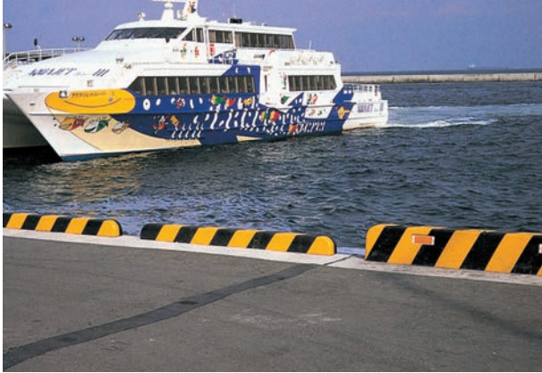
関西新空港車止め
