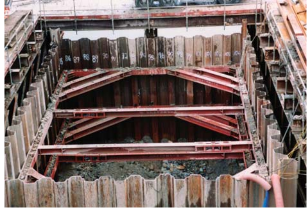
パイルロック使用例：河川内への橋脚施工
