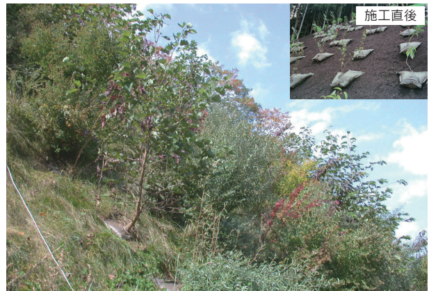
切土法面を早期樹林化（岐阜県・施工2年後）
