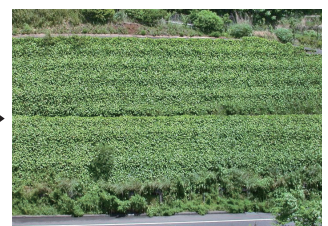
法枠・受圧板を、つる植物で被覆修景
