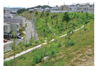
宅地造成地の切土法面緑化
