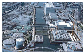
パトレシアとセルカによる震災時の緊急下水処理沈殿池
