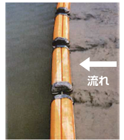
埋立工事の汚濁拡散防止
