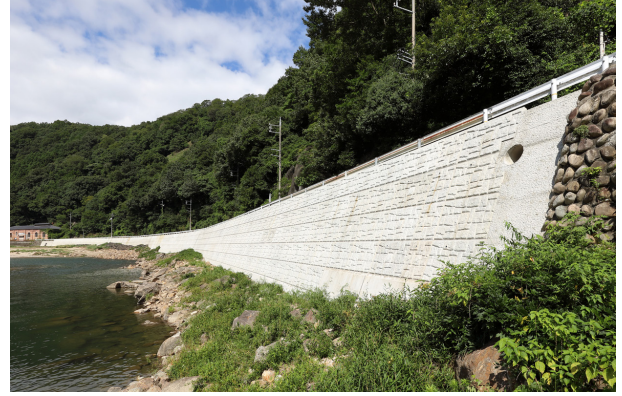
道路の谷側拡幅の例 (広島県広島市) 勾配 1:0.4 最大高5.6m
