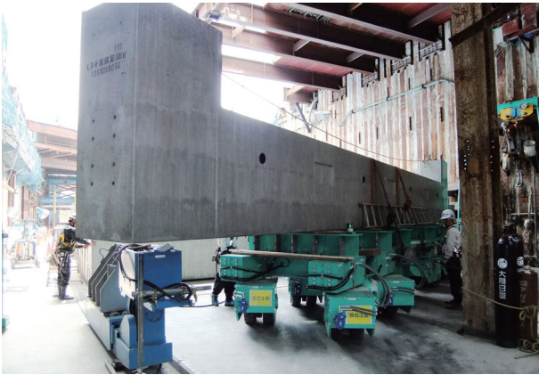
施工例（4分割大型断面底版部）
