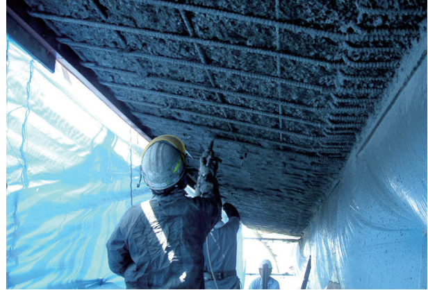
リフリート工法+RF 厚付モルタル SP
