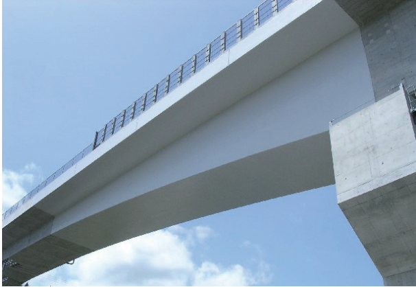
リフリート工法+TM ネット工法
