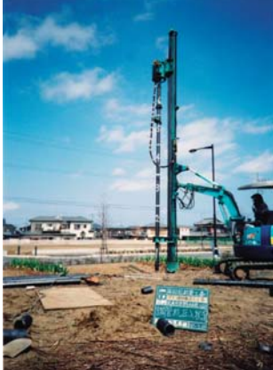
施工現場風景
