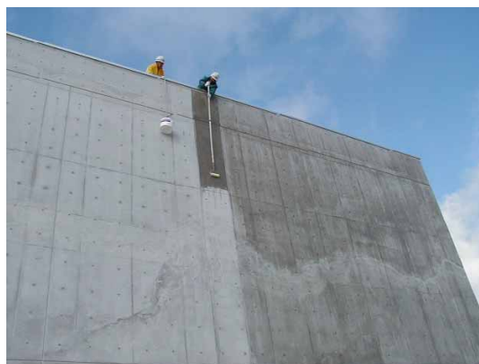
足場が無くても長いローラーを用いて塗布している状況
