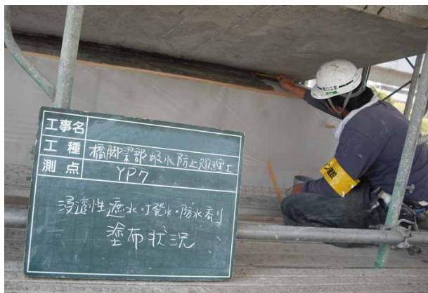
ナノコンスーパ塗布状況
