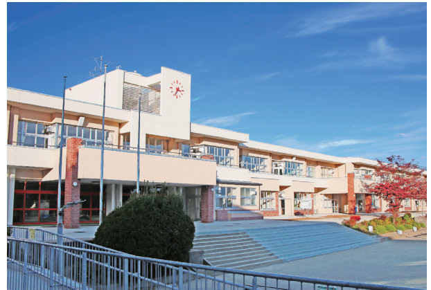
施工例 (福岡市立甘利小学校校舎)
