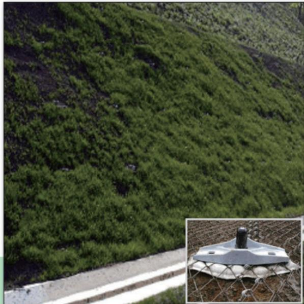
高強度ネットとクモ用プレートおよび補強材などを組み合わせ、深さ3.0m以下を標準とした地山補強土工法。表層破壊を抑止するとともに、崩壊土塊の中抜けを抑止する。全体の安定については補強工により、補強材間の中抜けについては高強度ネットの引張力により抵抗する。抵抗力は、クモ用プレートと高強度ネットの交点数が有効となる。補強材間隔は2.0mである。切土斜面、樹木の繁茂していない自然斜面、崩壊後の斜面安定対策工など、表層崩壊防止の法面工事に適用される。NETIS 活用促進技術登録。
