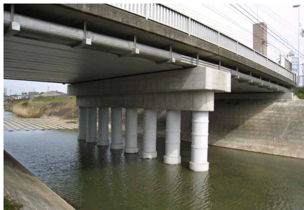
施工例 (橋脚耐震補強)
