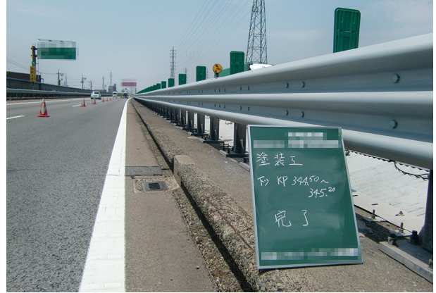
施工実績 (道路：ガードレール)
