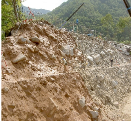
仮設吹付工実施状況
