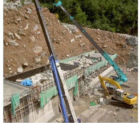
本施工実施状況
