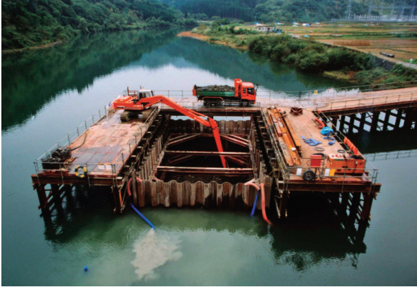
パイルロック使用例：河川内への橋脚施工
