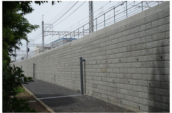
鋼矢板表面の被覆補強と修景（高架鉄道耐震補強工事）
