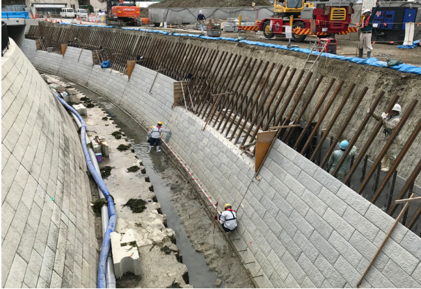
施工例（護岸擁壁の改築補強と修景）
