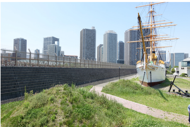
乾ドック調石積み擁壁（上半分が階段形状からなる修景擁壁）
