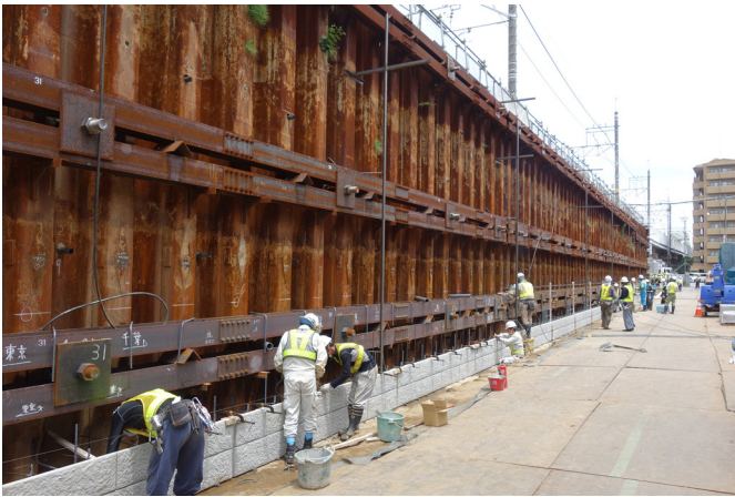
鋼矢板表面の被覆補強と修景（高架鉄道耐震補強工事）
