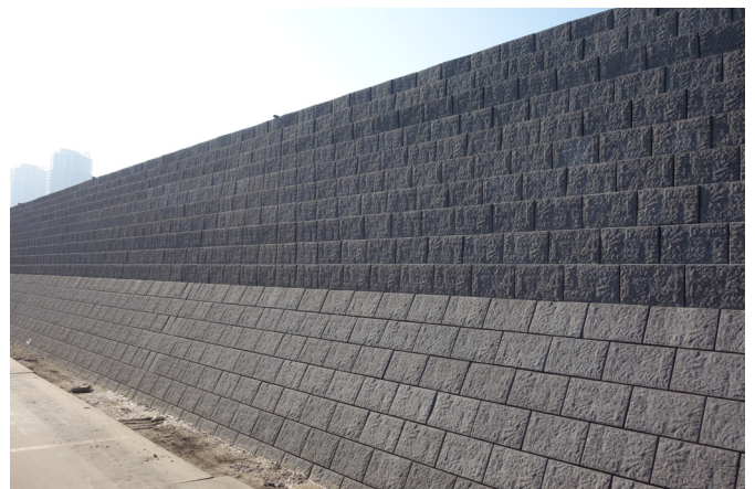
乾ドック調石積み擁壁（上半分が階段形状からなる修景擁壁）
