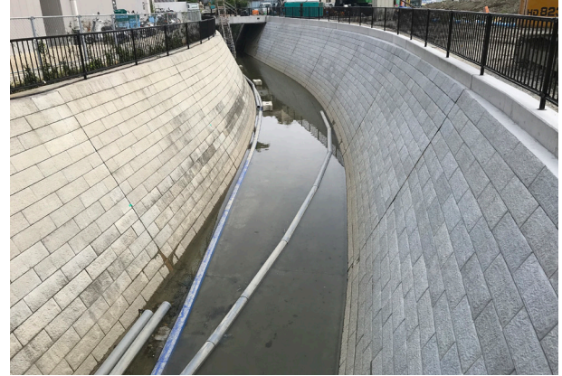
施工例（護岸擁壁の改築補強と修景）
