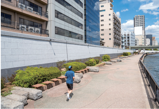
隅田川両国橋上下流護岸
