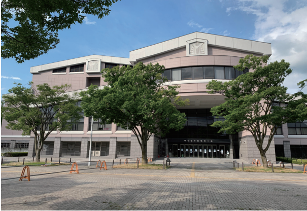
施工例（キッセイ文化ホール改修工事）
