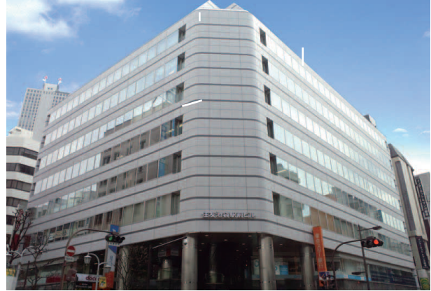
施工例（住友池袋駅前ビル外壁修繕工事）
