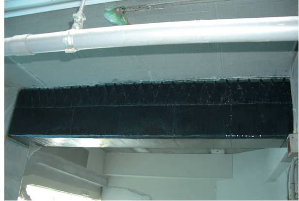
東京メトロ南千住駅舎梁補強仕上前
