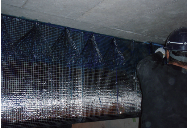
酒匂川左岸流域処理場ポンプ場梁補強CFアンカー取付け
