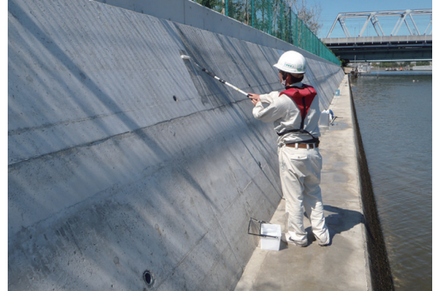
T&C防食-塩害用- 施工中
