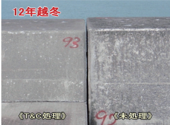
T&C防食施工後12年を経た防波堤
