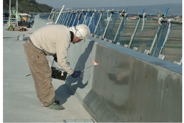
クリスタルストーンNR 施工中
