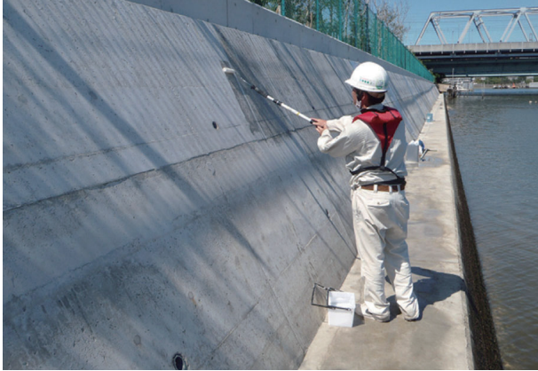
T&C 防食一塩害用一 施工中
