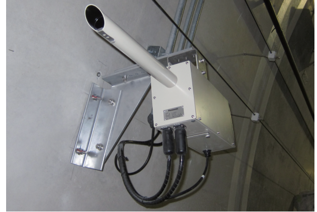
①煙霧透過率測定装置 左：受光部 右：投光部
