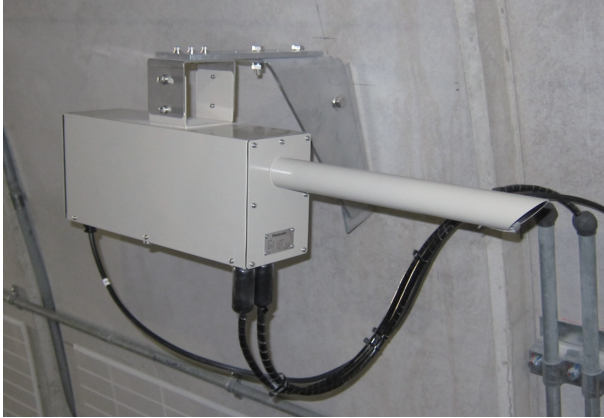
①煙霧透過率測定装置 左：受光部 右：投光部
