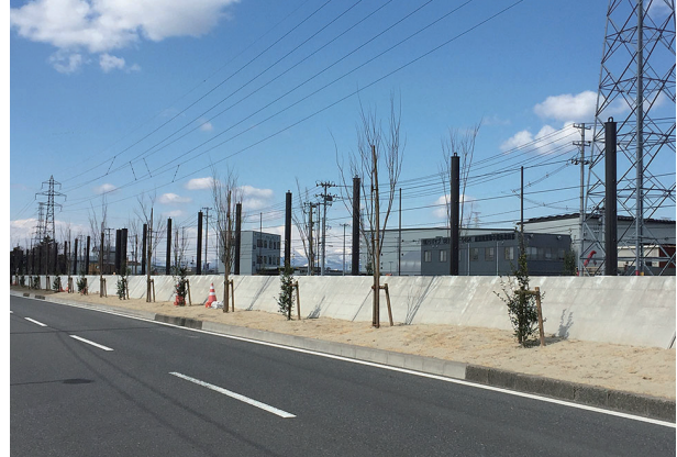
設置例 (宮城県仙台塩釜港)
