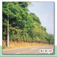
自然回復緑化・自然侵入促進工に対応した緑化工法で、国内最大の施工実績(令和3年度末現在:2,780,000㎡)を有する。法面上に耐久性のある特殊袋状マットを敷設し、アンカーピンで固定した後、その中に種子および植物の永続性を考慮した特殊有機質資材と特殊生育基盤材を水と混合し、客土注入機械にて袋状マットに圧送・注入する。これにより、浸食作用を受けない注入基盤(生育基盤層)が造成され、土砂から岩盤までの無土壌地、急な斜面にも長期間安定した法面保護を可能とし、自然の回復を促進する。表層浸食が著しい法面の生育基盤層を施工直後から保護する。
