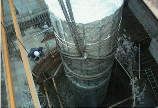
杭引抜き作業の様子 (φ1800mm)
