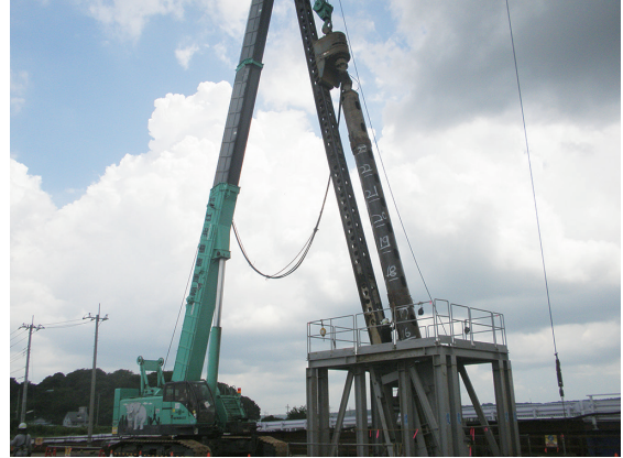
斜杭引抜き補助装置施工 (橋梁仮設ステージ足場)
