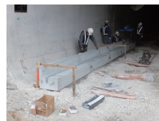
製品据付完了
