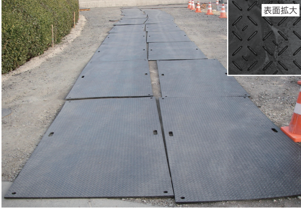
仮設道路としての使用例。軽量な為、人力で容易に設置できる
