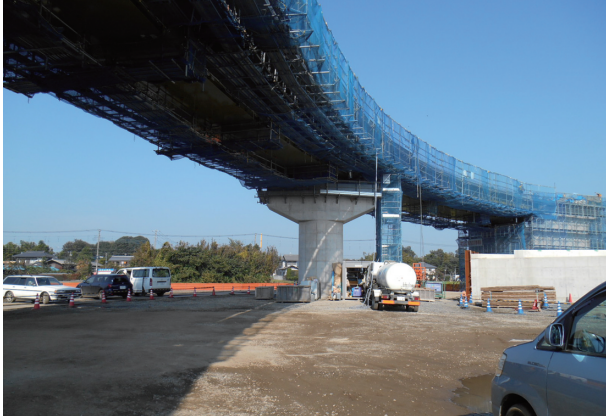
高速道路橋上部工事風景
