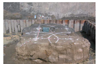
エキスパッカ工法によるパーマロックの固結体
