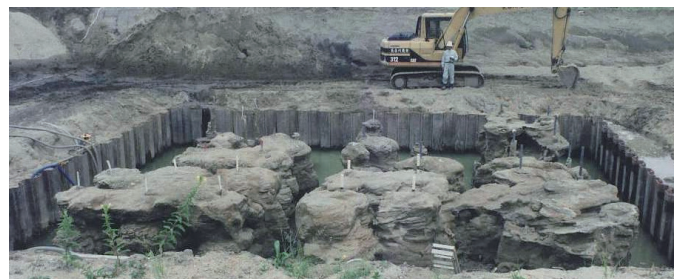
注入地盤の開削による確認 (全景)
