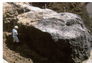
超多点注入工法によるパーマロックの固結体
