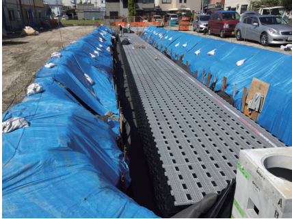
宅地造成 施工中
