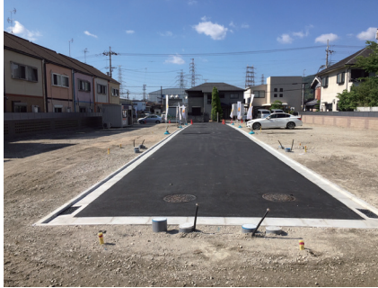
宅地造成 完成
