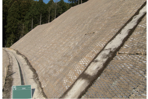
レミフォレスト工法 (施工直後)
