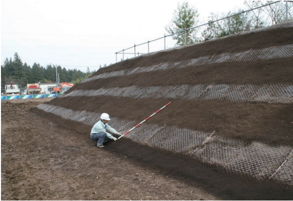
エコストライプ工法 (施工直後)
