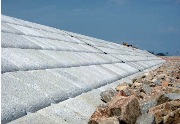
施工例 (谷地小屋工区 漁港海岸災害復旧工事)
