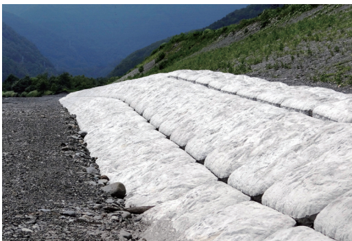
施工例 (H25 中部横断飯富地区工事用道路設置工事)
