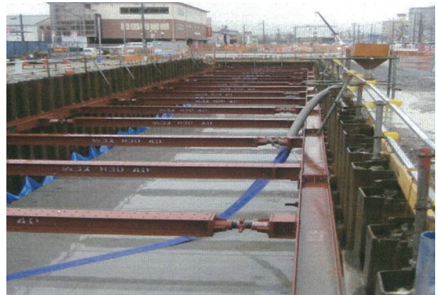
ランソイル ® 充填状況
