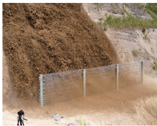
流出土砂衝突時の状況
