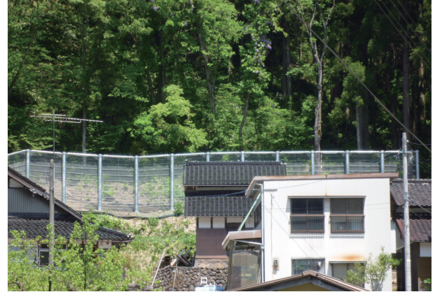
HEF 工法 施工事例 (富山県南砺市小二又)
