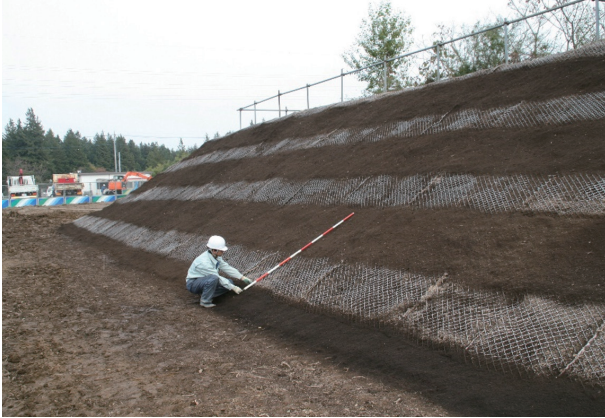
エコストライプ工法 (施工直後)
