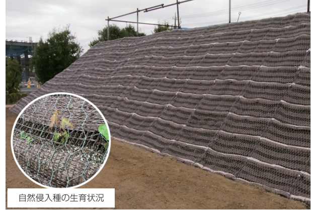
ニューレミフォレスト工法 (施工直後)
