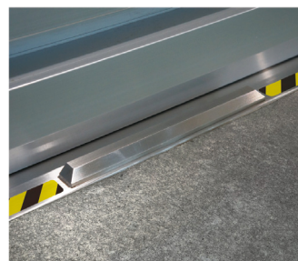
屋内側に設置された耐水圧受けで浸水時に止水板にかかる水圧を受けられる (W=4m以上)
