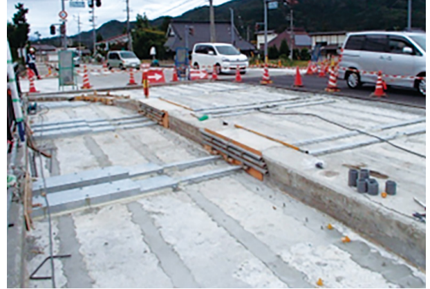
アウトプレートによる橋軸直角方向の補強
