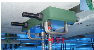
新型ジャッキによる緊張状況
