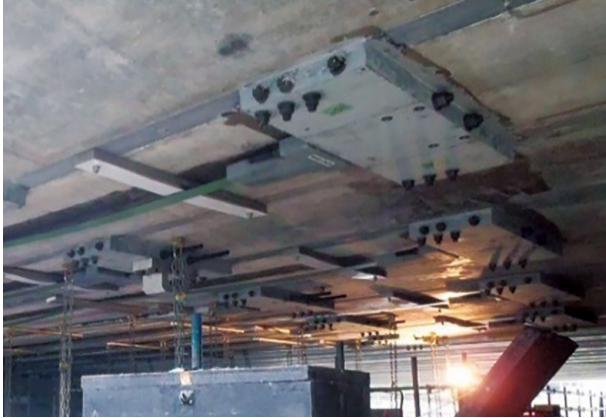
アウトプレートによる橋軸方向の補強
