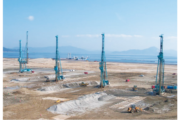
動的締固め (SCP) 工法 施工状況
