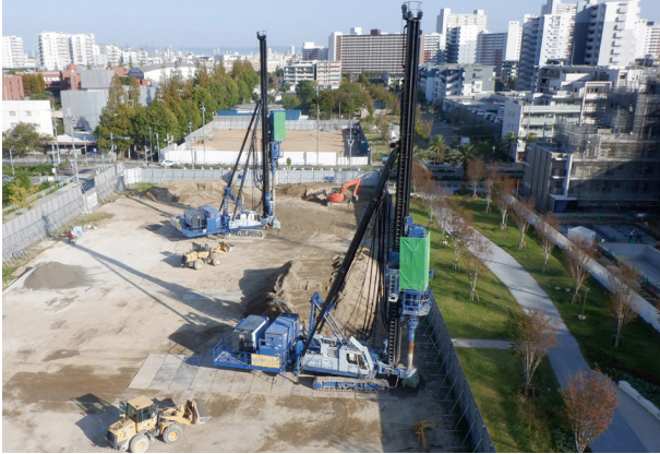
静的締固め (SDP-Net) 工法 施工状況
