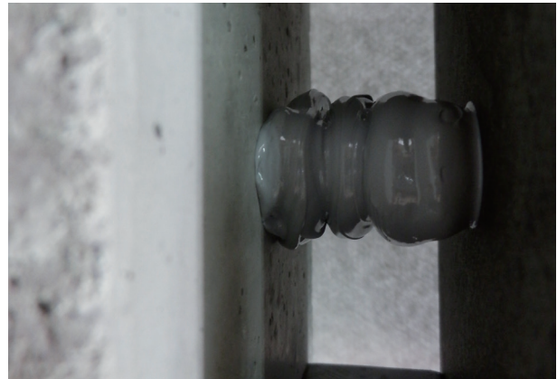
FS コラム工法 樹脂注入状況
