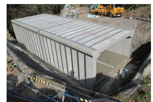
⑥施工完了
