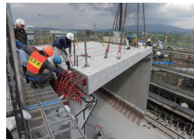
③頂版スラブ架設
