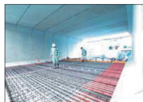
⑤底版部の配筋
