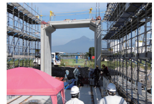
②側壁施工
