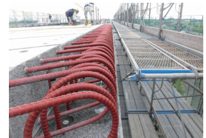
④頂版隅角部の配筋状況
