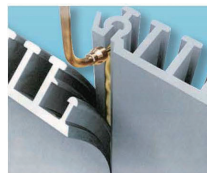
接着剤注入時
