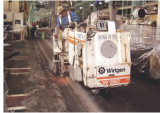
切削（レベルダウン）施工
