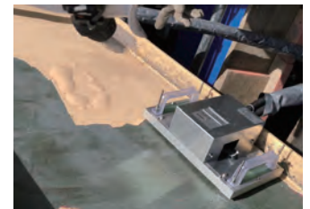
IH式塗膜剥離
