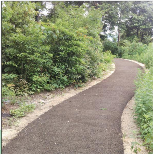
田中建材が技術開発した「ハーモニーロードウッド」は、地域で発生した建設廃材や間伐材などの廃木材の破砕チップを舗装材料とした木質加熱アスファルト舗装で、主に公園の遊歩道や建物の駐車場など外構部に活用されている。本製品は、砕石砂利を用いた舗装と比較して製造時に使用するエネルギーを削減することができ、歩行感も柔らかく膝への負担も少ない。国際規模のスポーツ施設外構にも採用され、断熱性能の優れた循環型材料としてヒートアイランドの低減、廃棄材のリサイクルを通して、環境保全に大きく貢献している。
