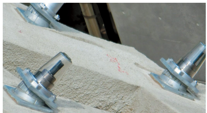
施工例 (Cグレード)
