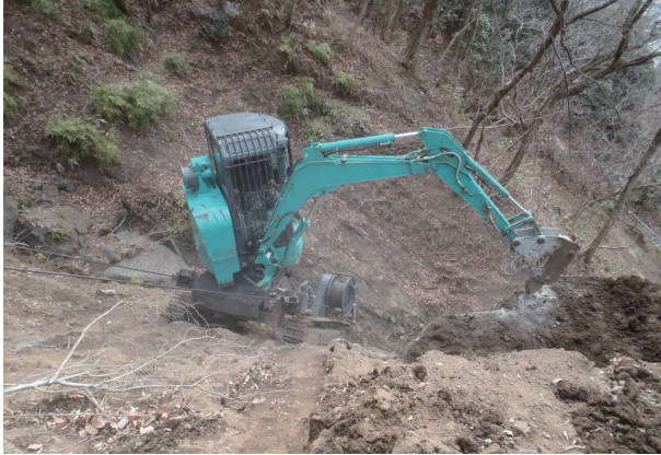
災害復旧現場で稼働する RCM03
