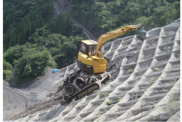
破砕カッターで工事を行う RCM06
